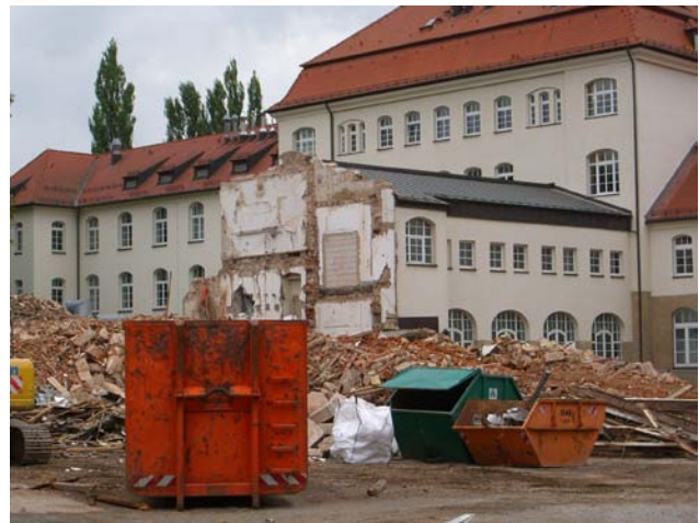
Abb. 1.1. Abbruch des Gebäudes Rembrandtstraße
