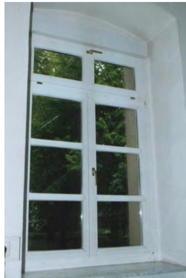
Abb. 11.1: Beispiel für eine mangelhafte Tageslichtsituation, ein Baum behindert den Lichteinfall erheblich (Quelle: LUA Chemnitz)
