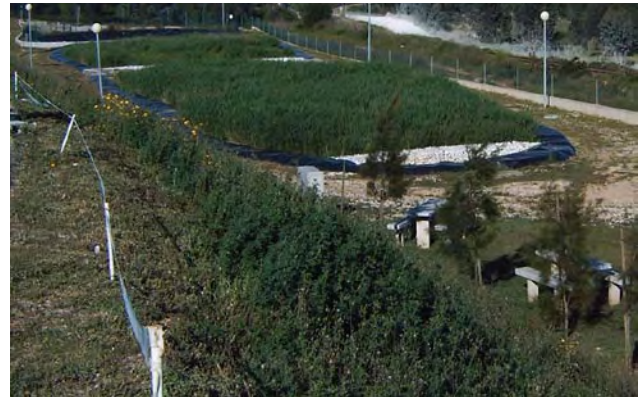
Abb. 12.1: Ansicht einer Pflanzenkläranlage für ein Siedlungsgebiet - Foto: P. Kuschk, Helmholtzzentrum für Umweltforschung-UFZ
