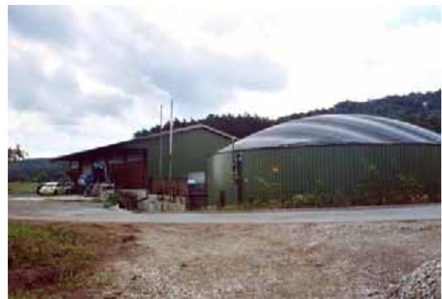
Abb. 9.6: Biogasanlage (Quelle: C.A.R.M.E.N. e.V.)
